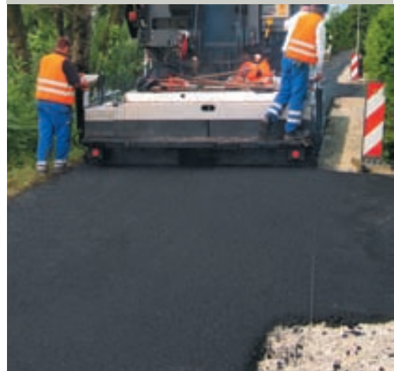
Максимальная ширина укладки до 10 м
