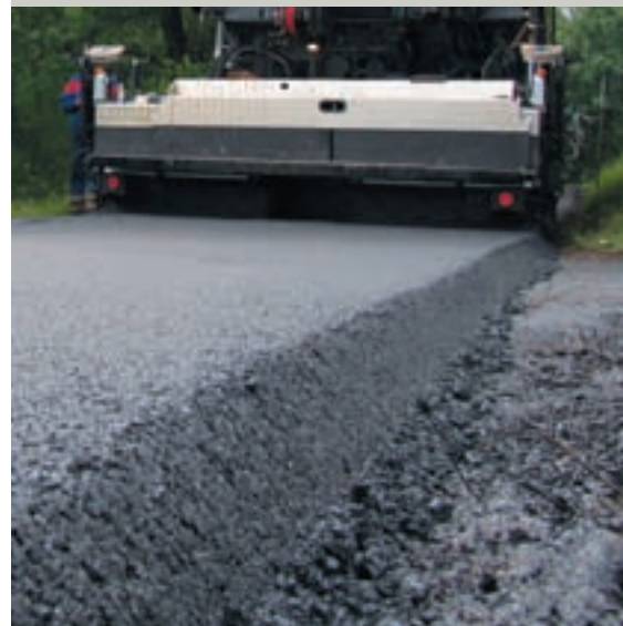
Толщина укладываемого слоя до 300 мм
