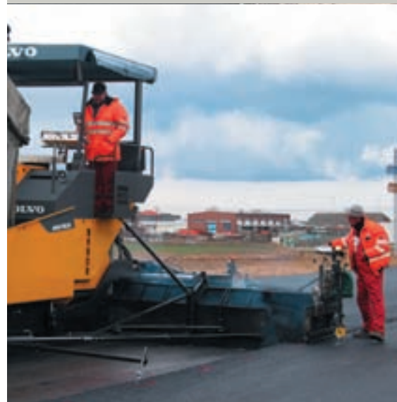
Толщина укладываемого слоя до 300 мм
